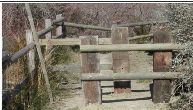
Exemple de chicane et barrière interdisant l'accès des véhicules – FEVRIER J., 2004
